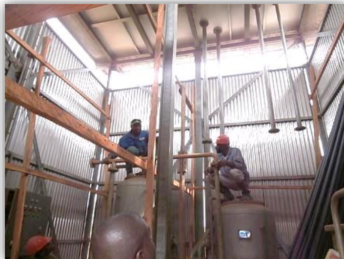
Intérieur de la station Scan Water en cours de réhabilitation (Nov. 2015)
